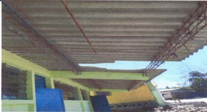
Foto 1: Área de cambio de techo de duralita de uno de los módulos por lámina troquelada aluzinc calibre 26
