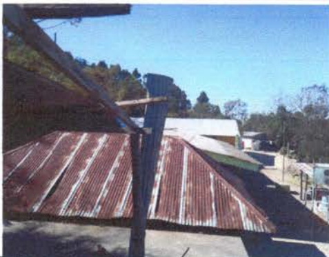
Foto 3: Cambio de techo de la cocina escolar.
